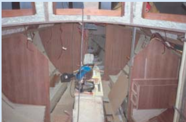
In Harlingen werden die Holzteile eingepasst
